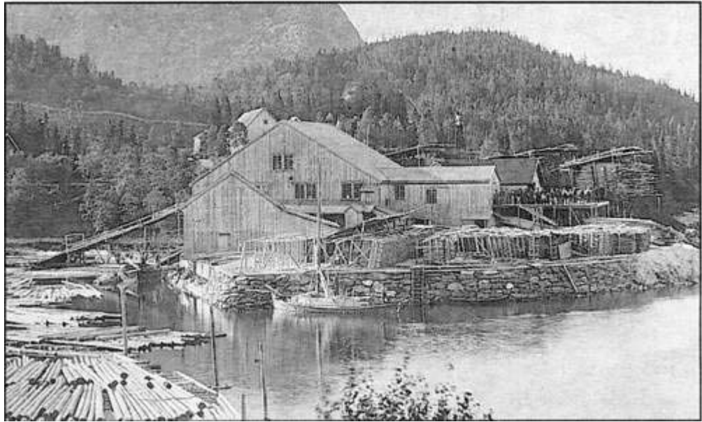
Fra den gang det ble drevet sagbruk i Kjærstadosen. Det var vanndybde opp til ca. 2-3 meter og også godt med vann på fjære sjø, Dersom det nå skal fjernes mer vann fra elva, ja da kan vi bare glemme at det finnes noen elv som heter Vefsna
